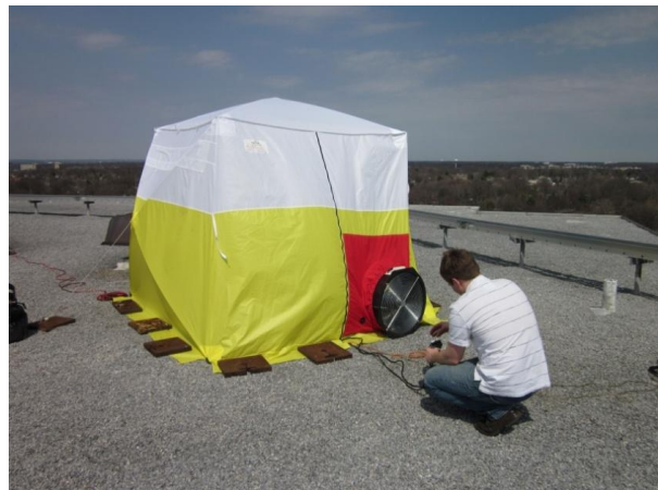
Roof Fan Tent in Use
